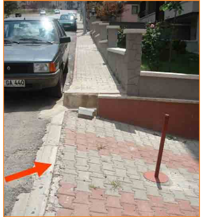
Otopark rampası parsel sınırı dışından başlatılmış ve komşu parselle arada kot farkı oluşturulmuş. Tehlikeli ve engelli bir kaldırım örneği...
