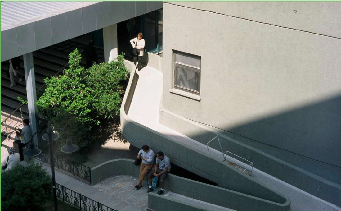
Merdivenin yanında uygun eđimde yapılmıř bir rampa.
