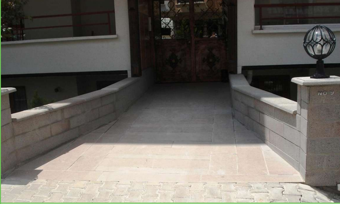
Dođru ve engelsiz bir bina giriři dzenlemesi... Kaldırımından bina ana giriř kapısına kadar engelsiz eriřebiliyor.
