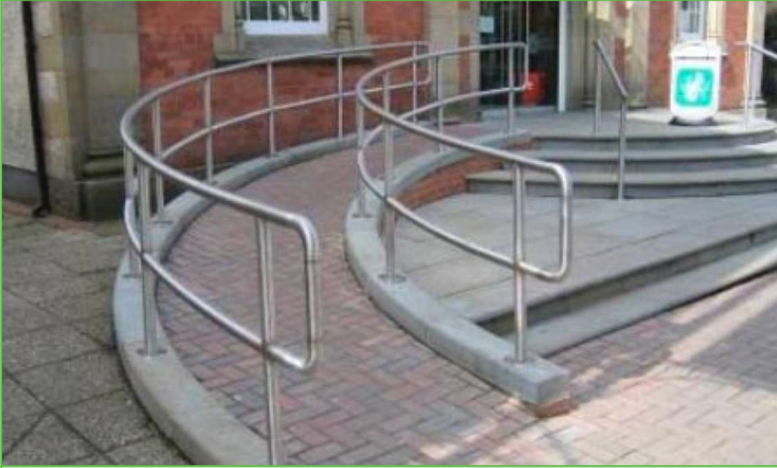
Merdivenin yanına yapılmış standartlara uygun bir rampa.
