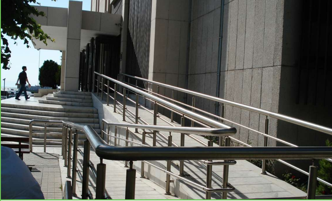
Merdivenin yanına yapılmış standartlara uygun bir rampa.
